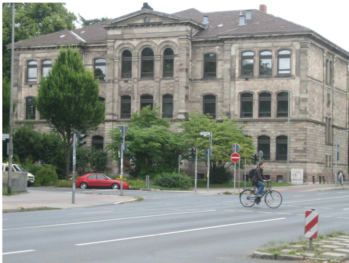
Das Schulgebäude 1880 bis 1913 (Herbartshule am Wall)
